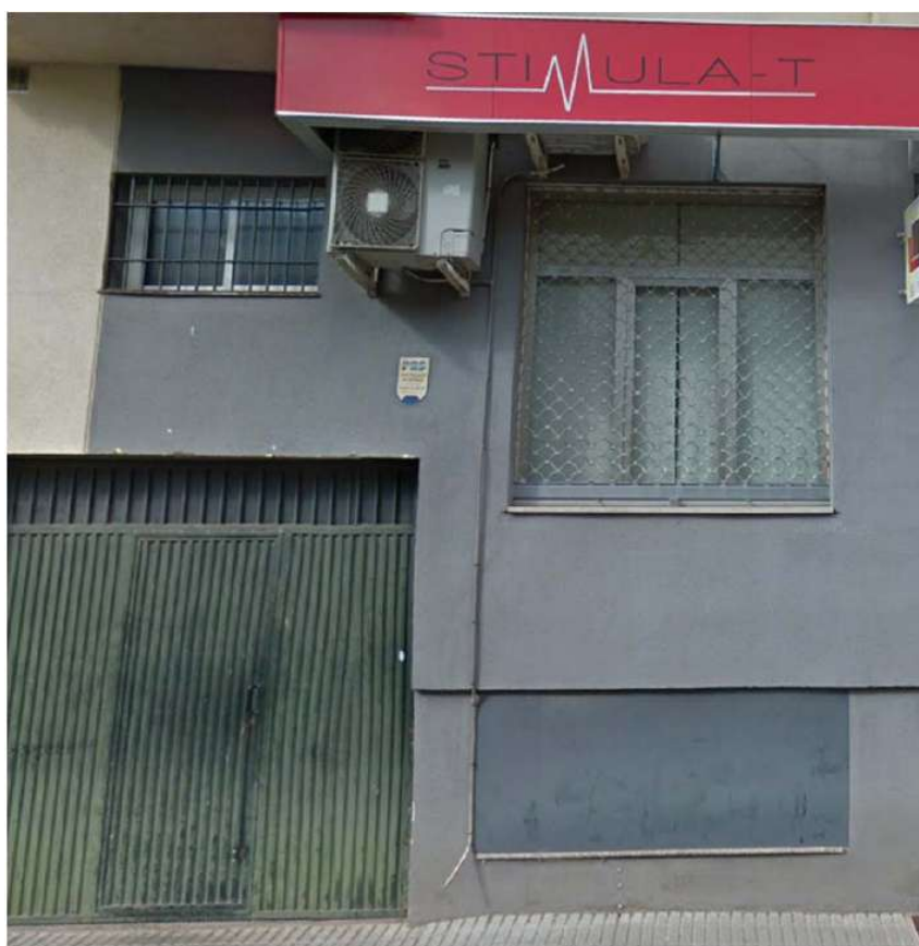
Estado actual fachada trasera del local por C/ Río Dílar
