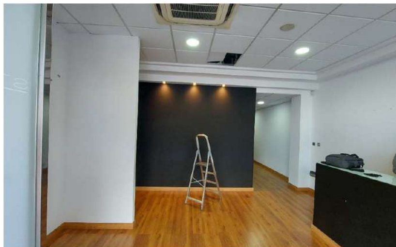
Estado actual del local
