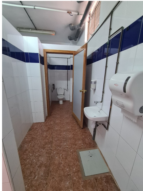
Aseo niños en planta baja a reformar
