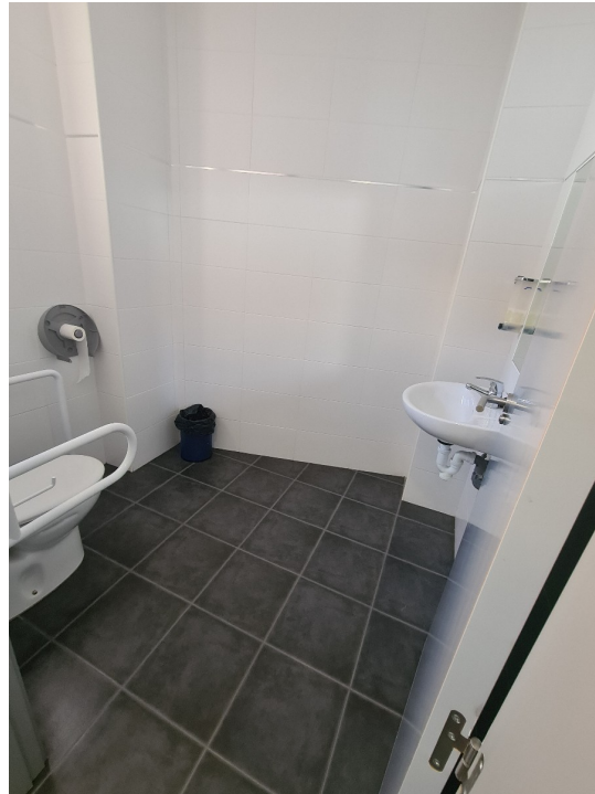
Aseo adaptado parcialmente en planta alta
