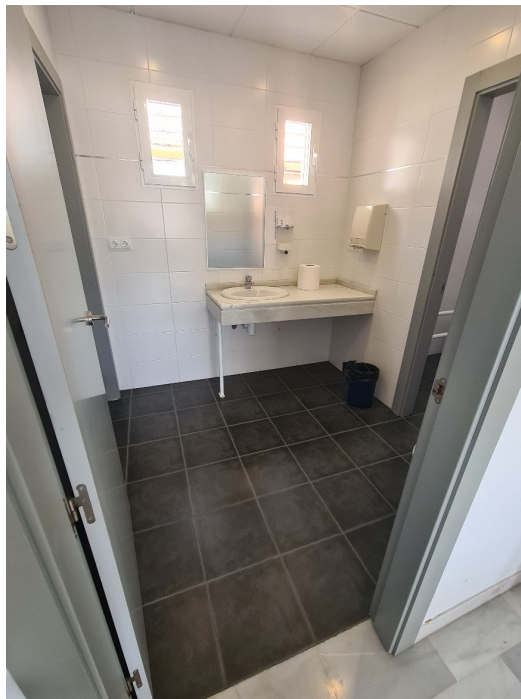
Vestíbulo aseos planta alta
