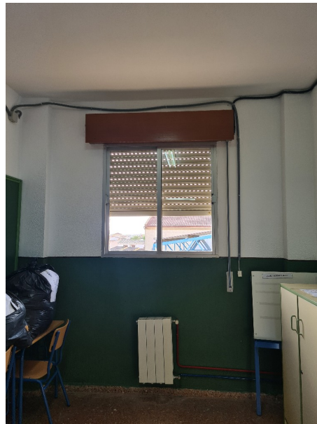
Desembarco del futuro ascensor en la planta primera
