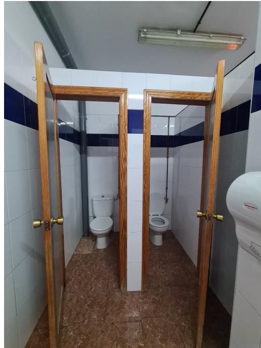
Aseo niñas en planta baja a reformar
