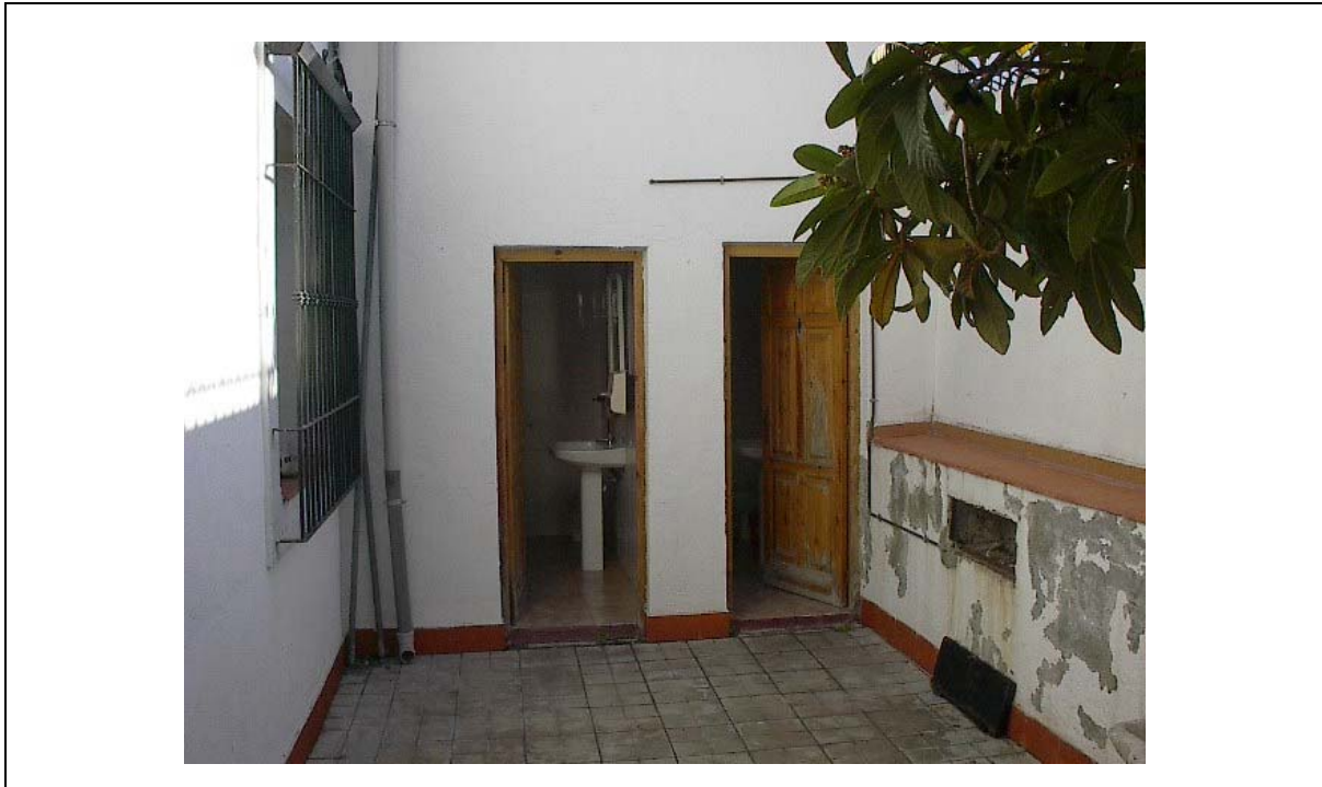
Foto 5 ASEOS Escalón de acceso
