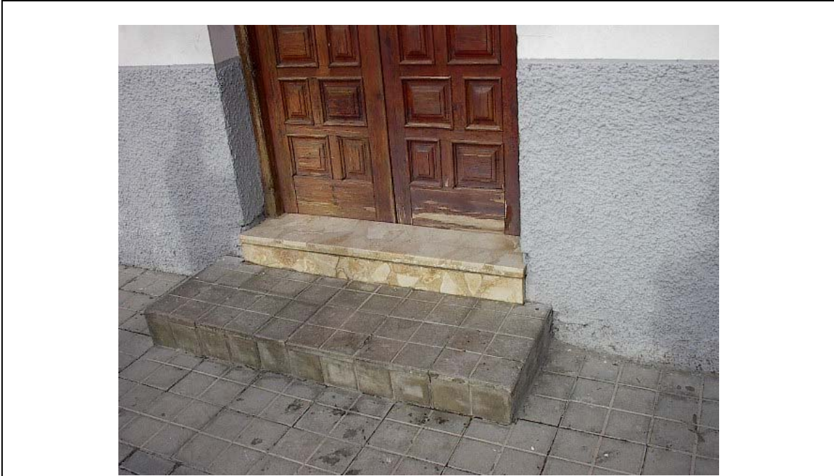
Foto 1 ESCALONES DE ENTRADA
