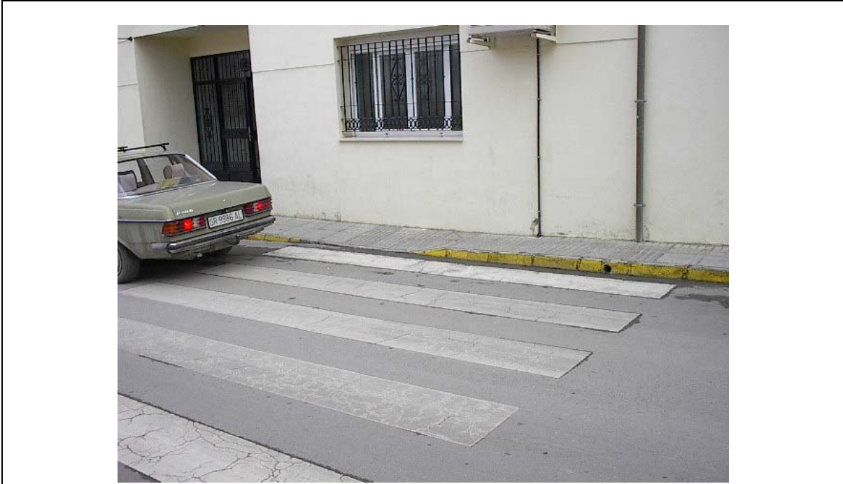
Foto 1 Paso de peatones de acceso al centro con vado de acceso
