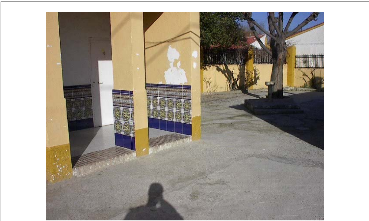
Foto 2 ACCESO A AULARIO con escalón
