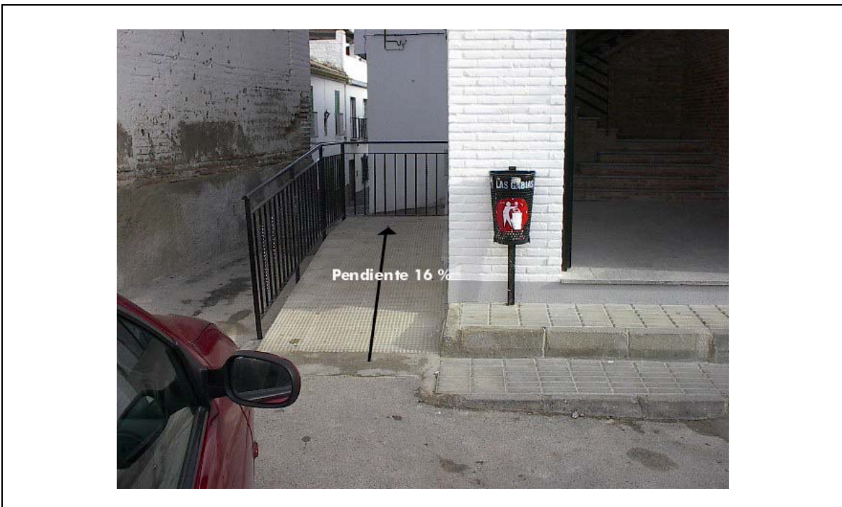
Foto 2 RAMPA DE ACCESO
