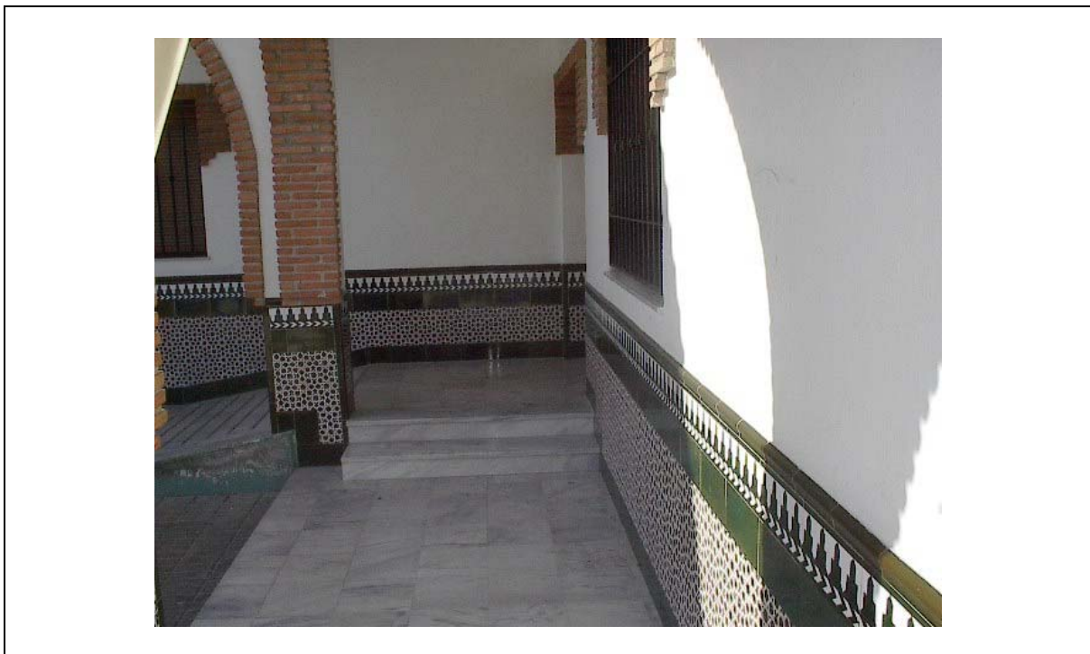
Foto 6 Escalones no salvados con rampa
