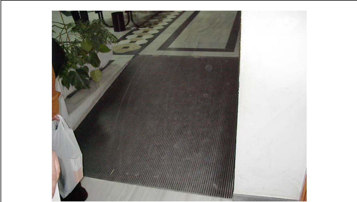
Foto 3 Rampa de acceso a consultas
