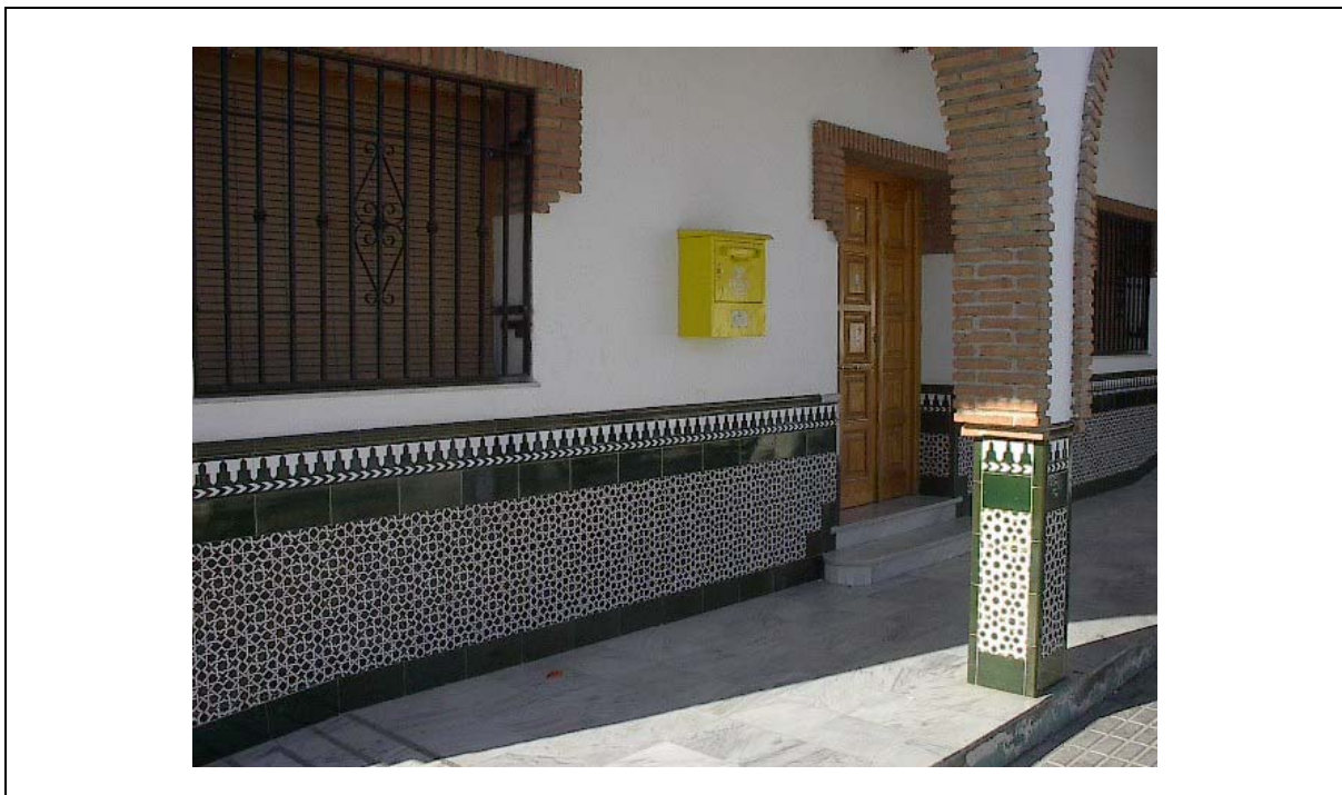
Foto 8 Escalones de acceso. Buzón no adaptado
