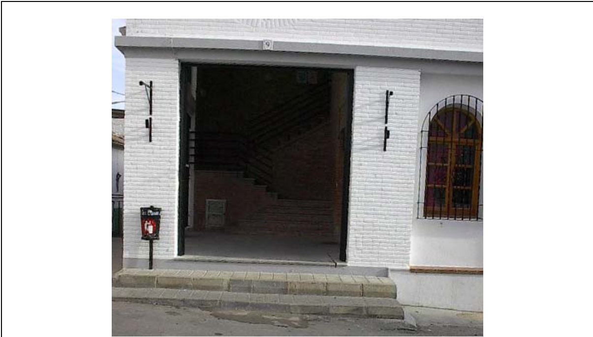
Foto 1 ESCALONES DE ACCESO A HOGAR DEL PENSIONISTA Y BIBLIOTECA Huellas 60 cm, contrahuellas 20 cm.
