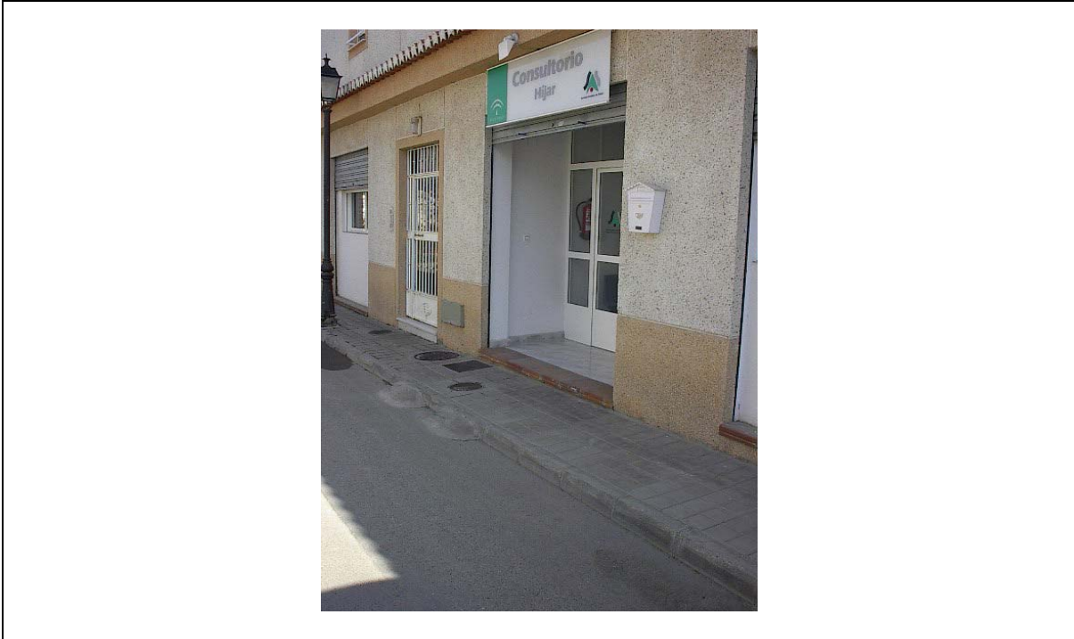
Foto 1 ACCESO CON ESCALÓN
