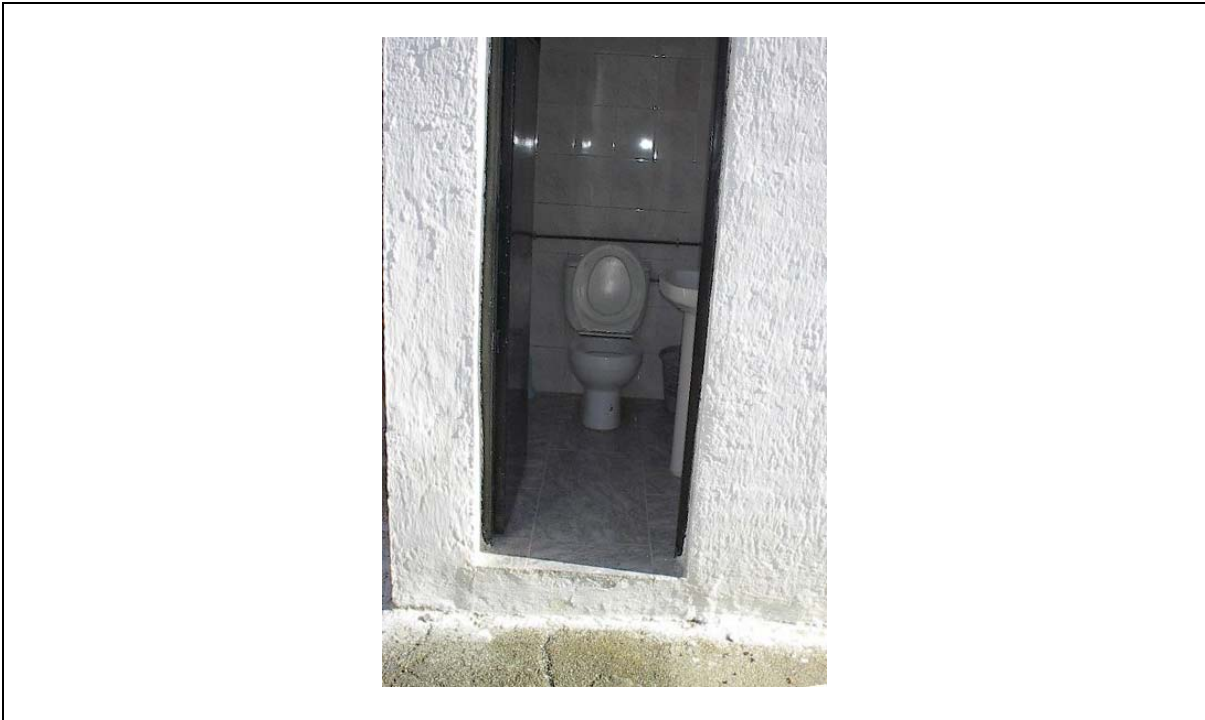
Foto 7 ASEOS NO ADAPTADOS Escalón de entrada, altura 20 cm, ancho de puerta 60 cm. Ancho de aseo 1,10cm.Fondo de aseo 1,70 cm. Mobiliario no adaptado.
