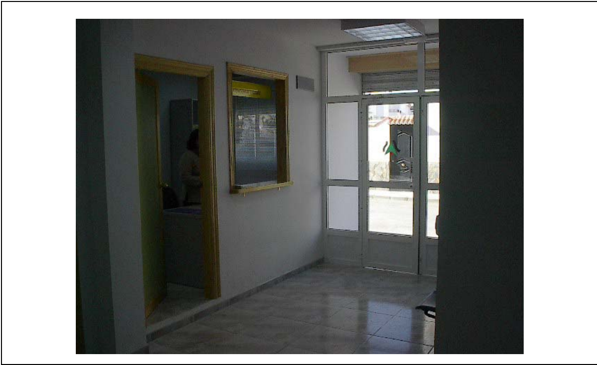
Foto 2 MOSTRADOR de atención al público no adaptado
