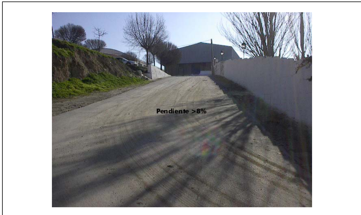
Foto 1 Calle de acceso
