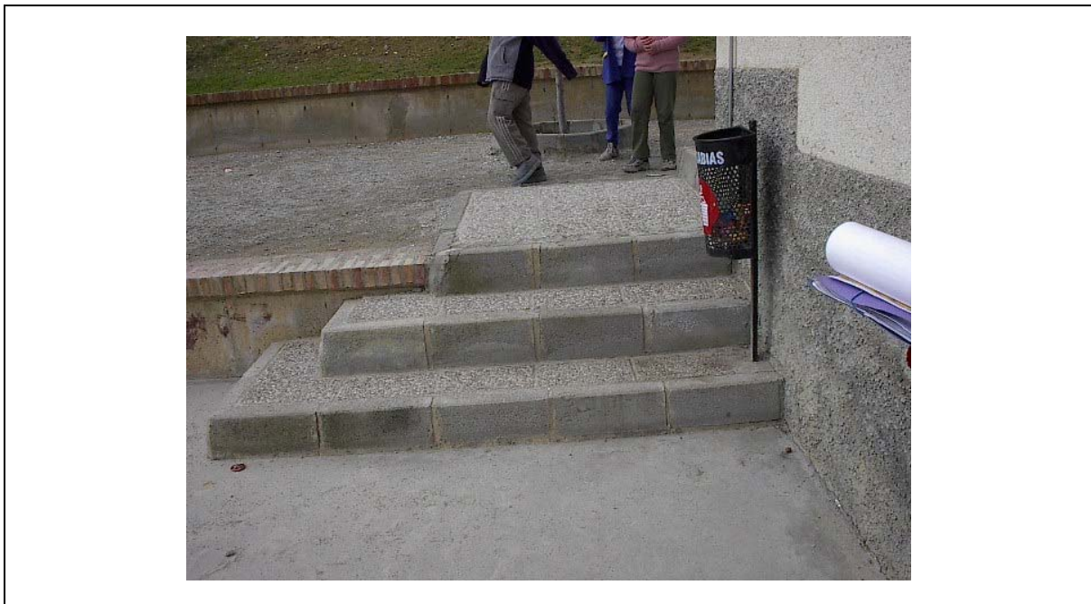
Foto 6 ESCALONES Contrahuella 19 cm. Altura de la boca de la papelera 93 + 19 cm.
