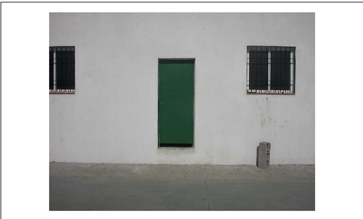
Foto 2 Escalón de entrada para acceder a vestuarios.
