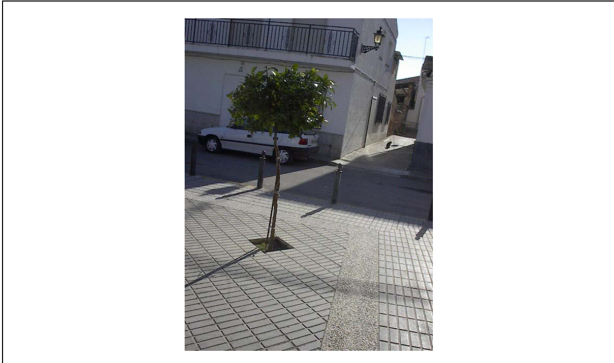
Foto 1 PLAZA DE ACCESO Alcorques no protegidos
