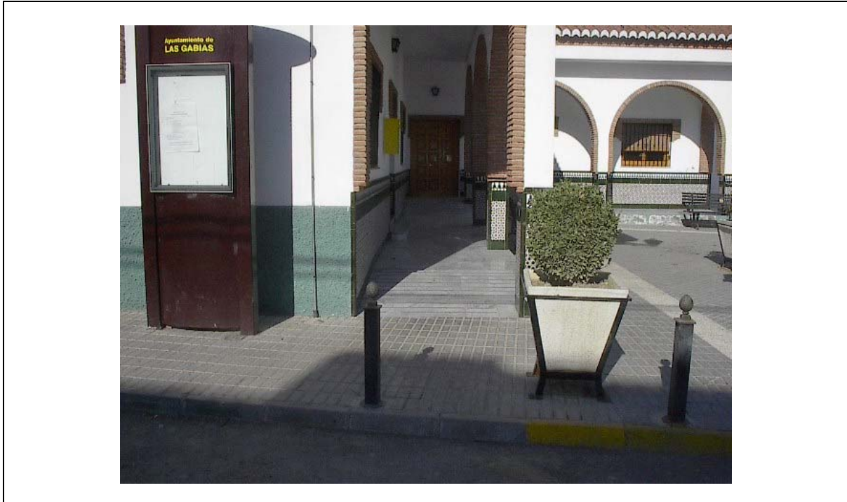
Foto 5 Acceso sin vado
