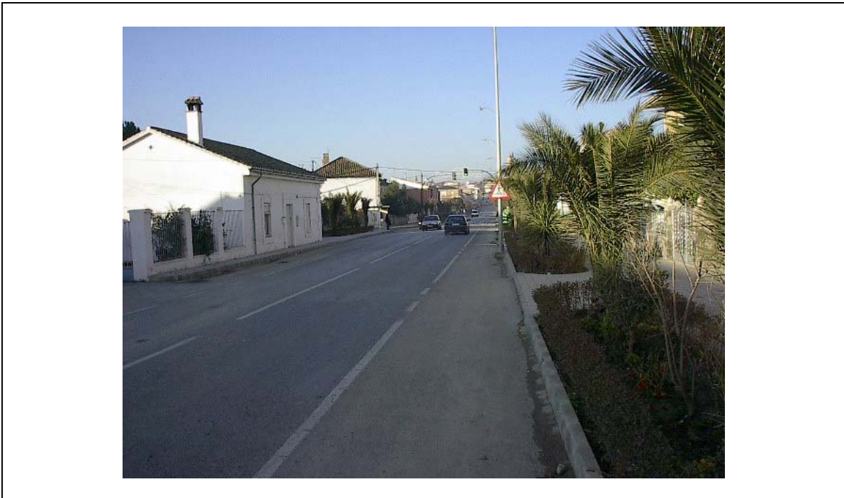
Foto 1 Vista de la calle
