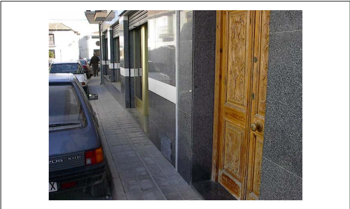
Foto 1 Acera ancho <1,20m.
