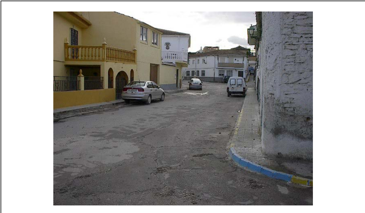
Foto 1 Aceras de acho inferior a 1,20 m. Sin vados de acceso
