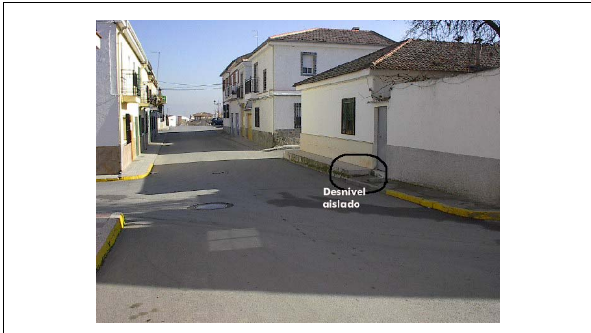
Foto 2 Aceras ancho < 1,20 m. Sin vados de acceso.
