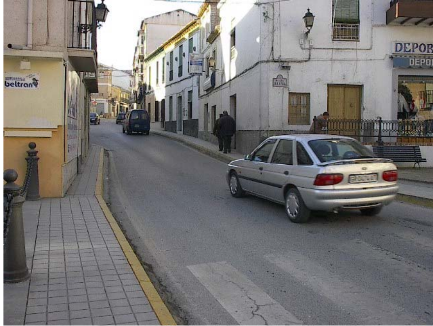
Foto 1 Vista de la calle. Estrechamiento de aceras < 1,20 m.
