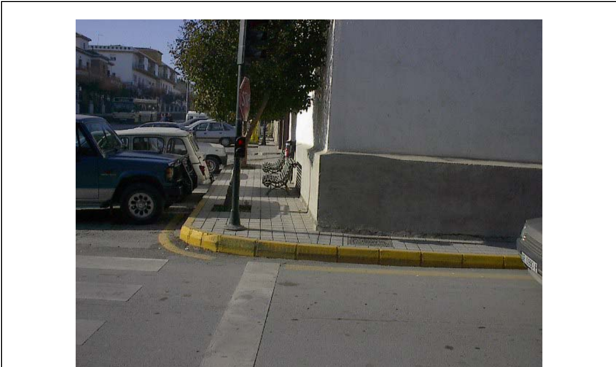
Foto 2 Mobiliario urbano que estrecha el paso de la acera <1,20m. Sin vado de acceso
