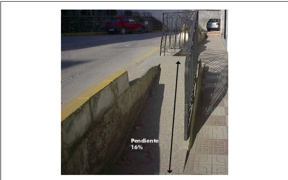
Foto 4 Rampa de acceso a la acera, ancho 1,10 m.
