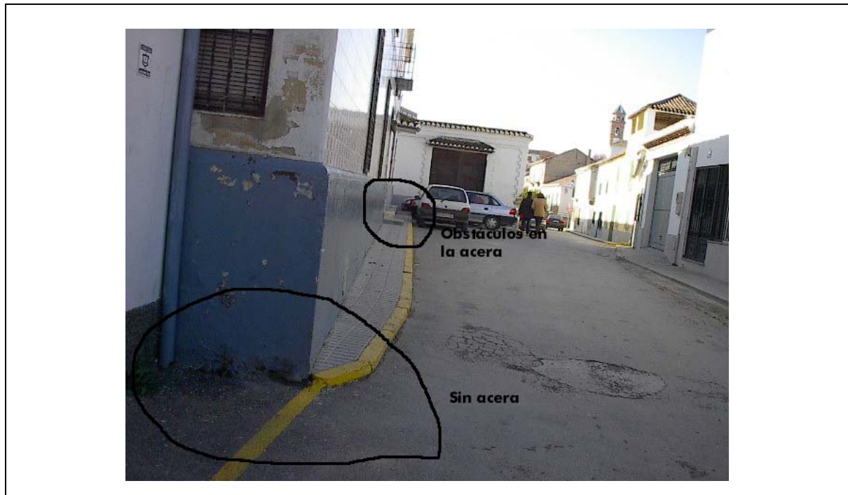
Foto 1 Aceras anchos <1,20m. Tramos sin aceras. Obstáculos en las aceras.
