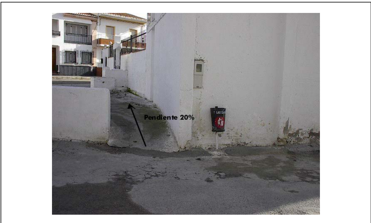
Foto 2 Rampa de acceso
