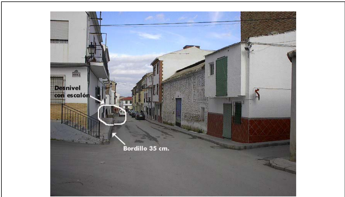
Foto 2 Aceras ancho < 1,20 m. Desniveles en aceras salvados con escalones
