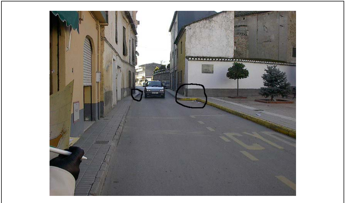
Foto 1 | Vista de la calle. Ancho de aceras < 1,20 m hasta el punto de dificultar el paso
