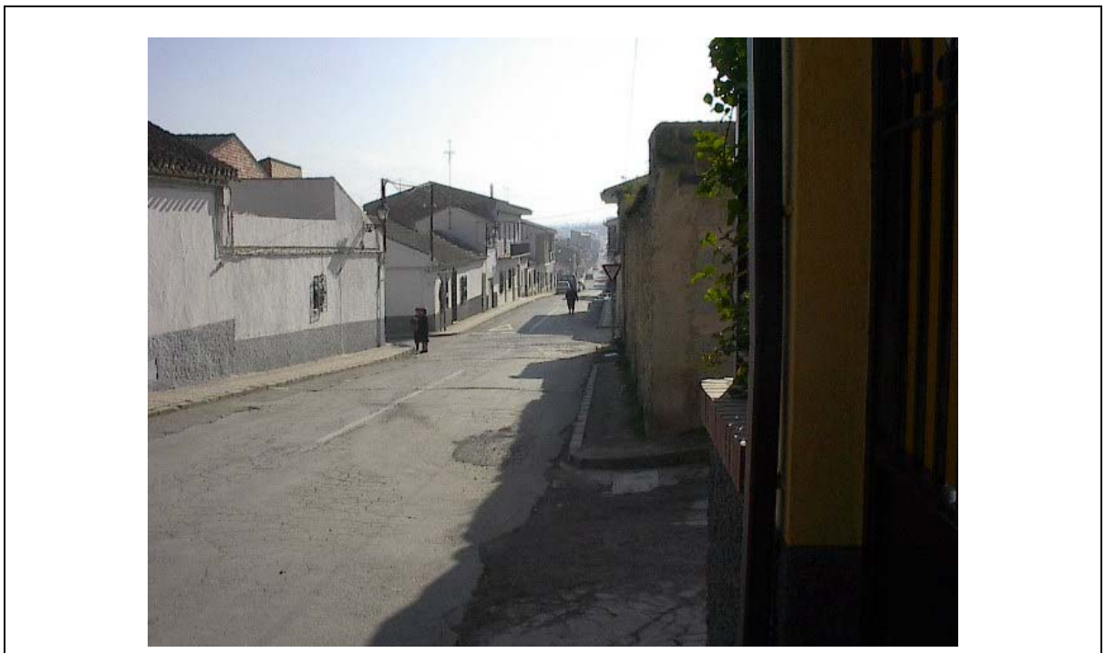
Foto 2 Tramos de acera sin pavimentar.
