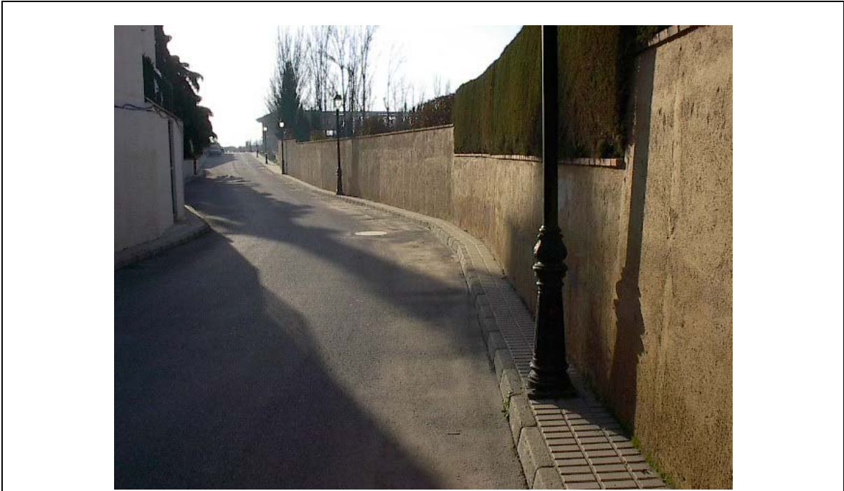
Foto 1 Vista de la calle. Aceras ancho <1,20. Con farolas que las ocupan impidiendo el paso por ellas.
