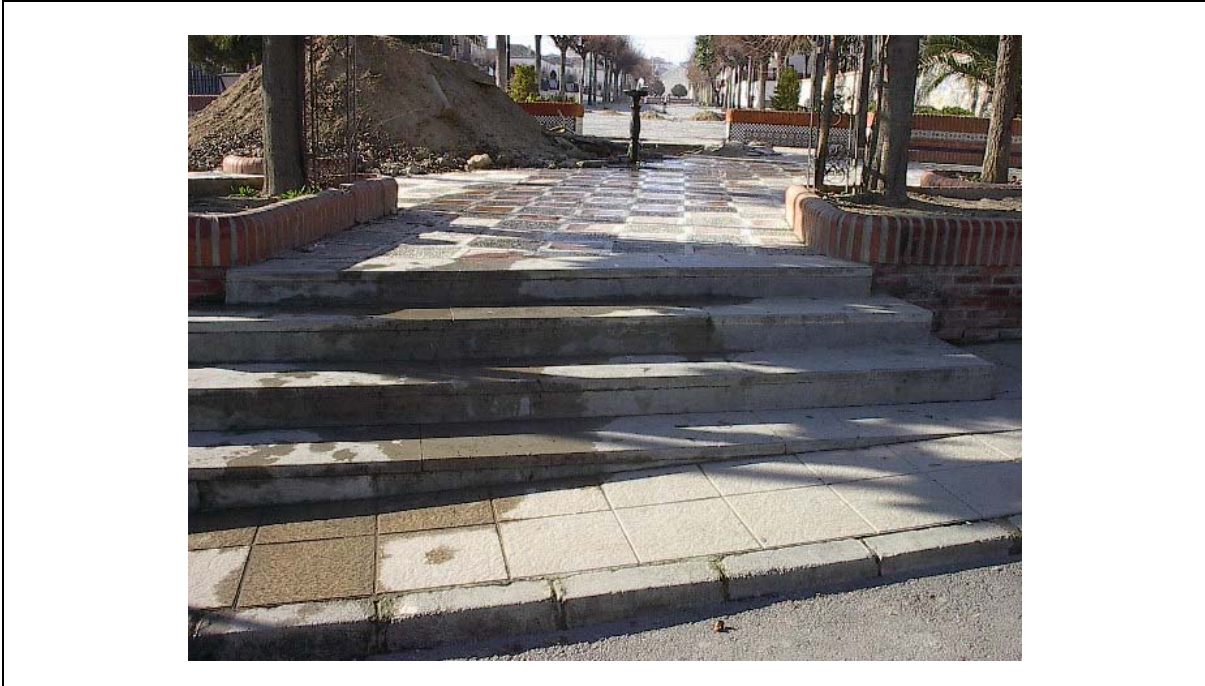
Foto 1 Escaleras de acceso: Huella 38 cm. Contrahuella 17 cm.
