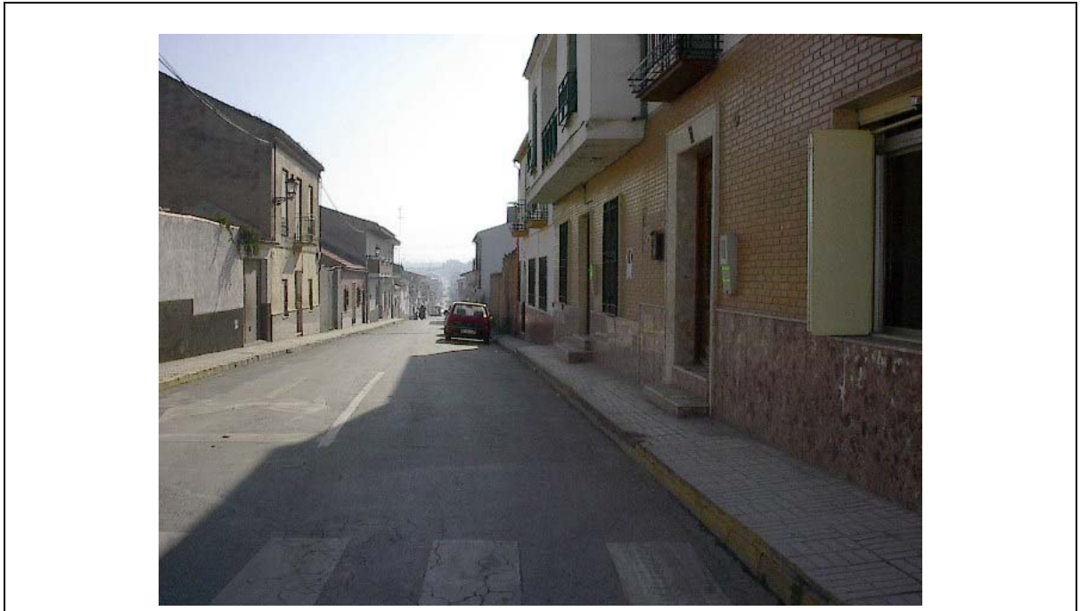
Foto 1 Aceras ancho <1,20m. Sin vados de acceso. Escalones en acera
