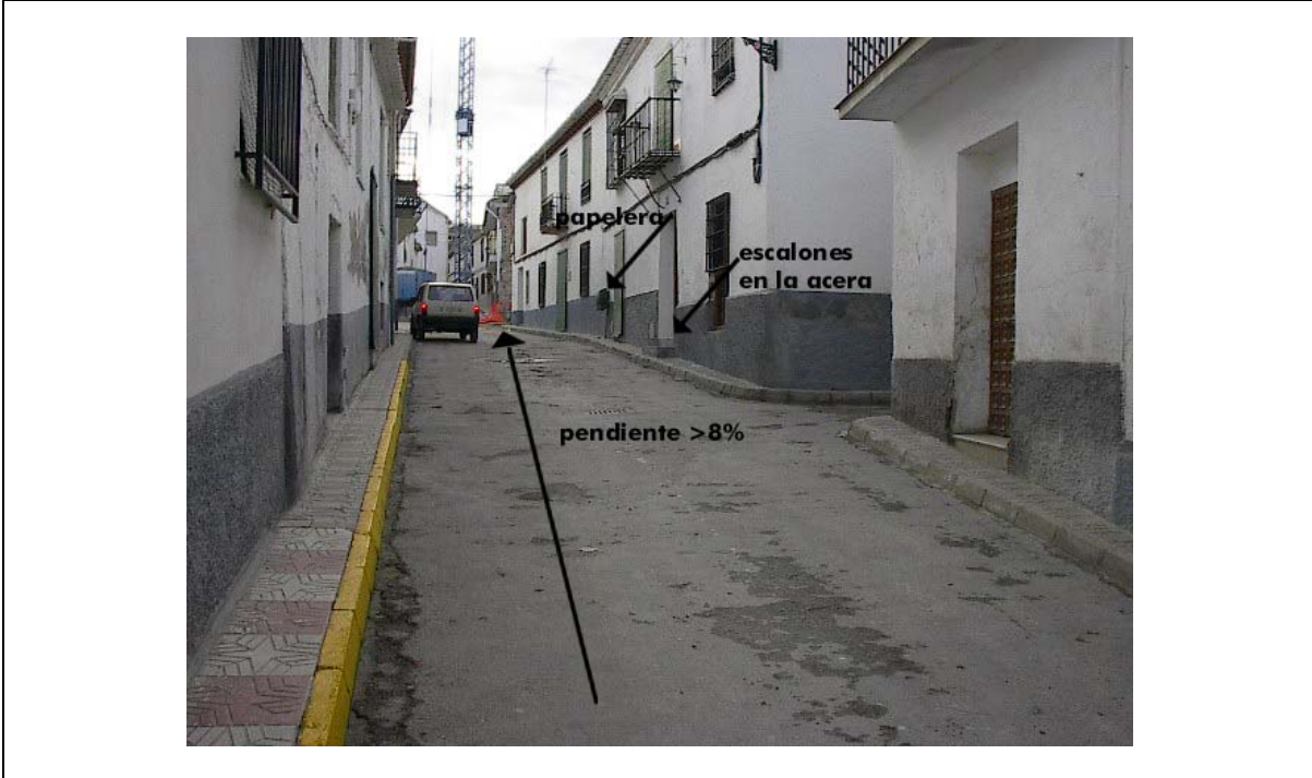
Foto 1 Aceras ancho < 1,20 m. Obstáculos en la acera (papelera y escalones) Altura de la boca de la papelera 1,10m.
