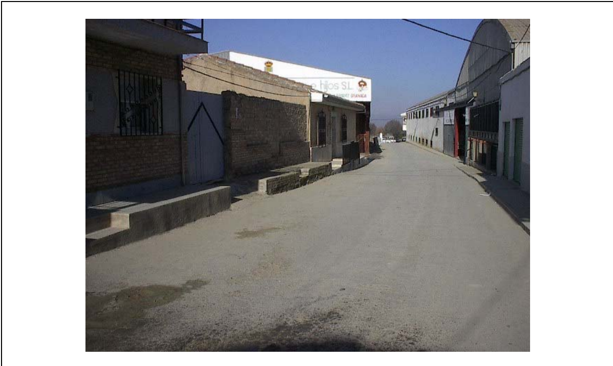
Foto 1 Vista de la calle. Aceras < 1,20m. Tramos sin aceras Desniveles salvados con escalones.
