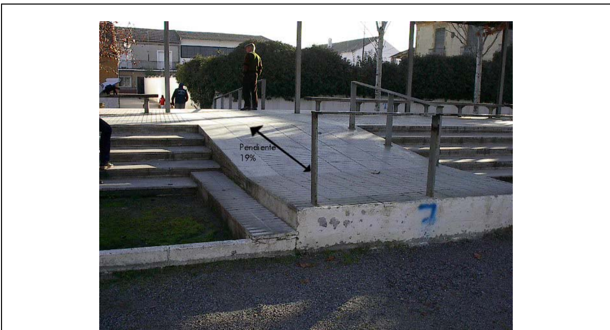
Foto 2 Rampa: Altura del pasamanos 80 cm.
