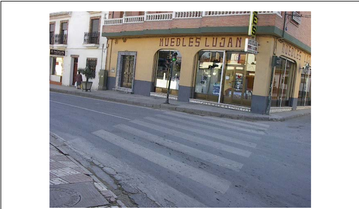
Foto 3 Paso de peatones sin vado
