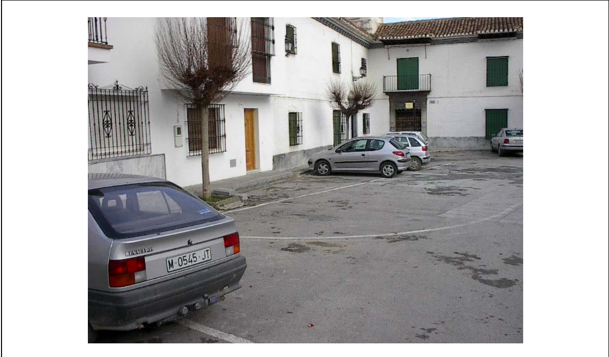
Foto 1 Ancho de aceras < 1,20 m. Aparcamientos sin reserva de plazas para minusválidos
