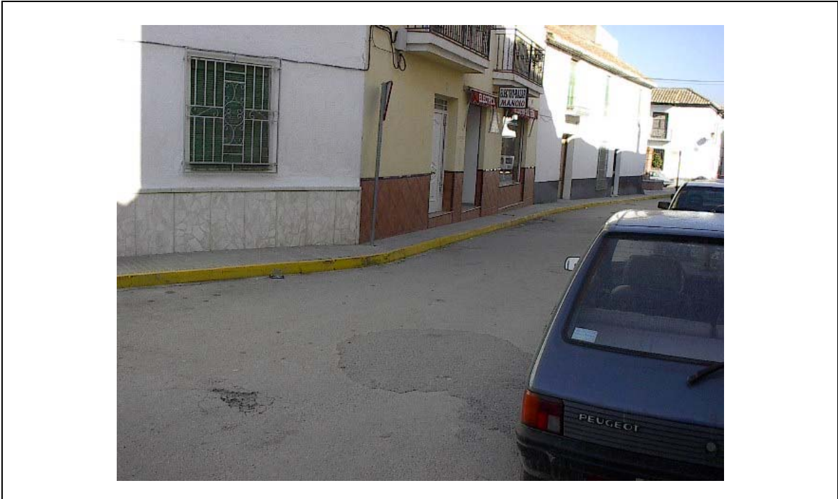
Foto 2 Acera ancho <1,20 m. Sin vados de acceso.
