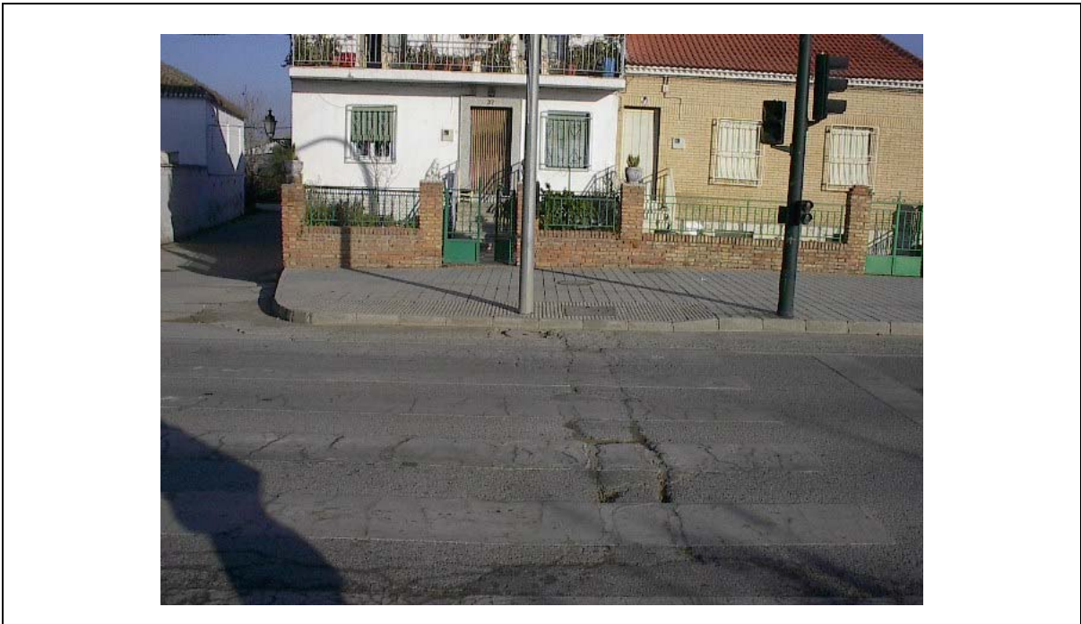
Foto 3 Paso de peatones con vado. Altura del vado 12 cm.
