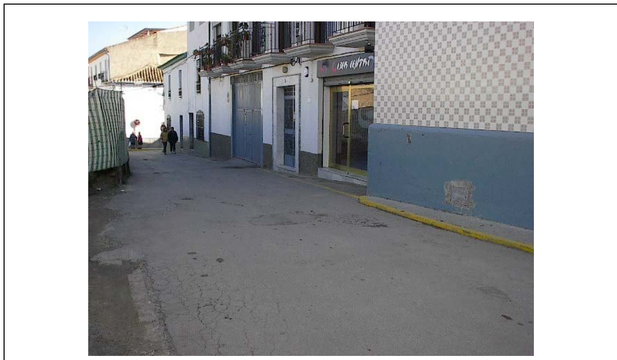
Foto 2 Tramo sin aceras
