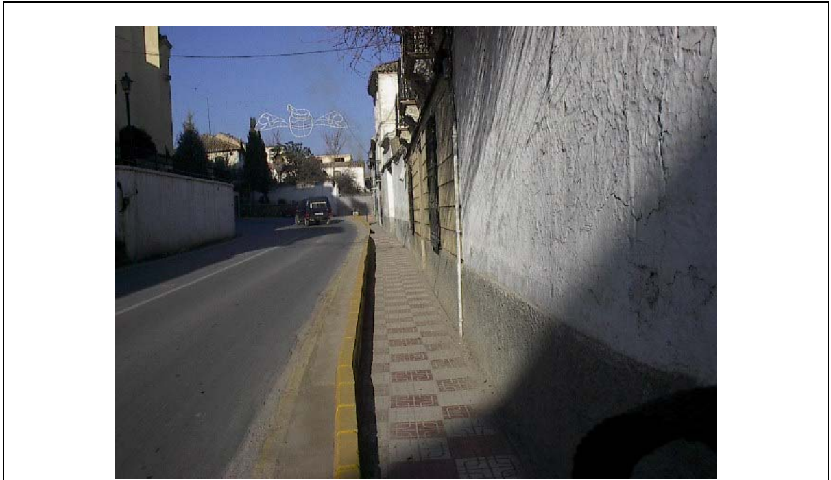
Foto 2 Acera ancho < 1,20 m
