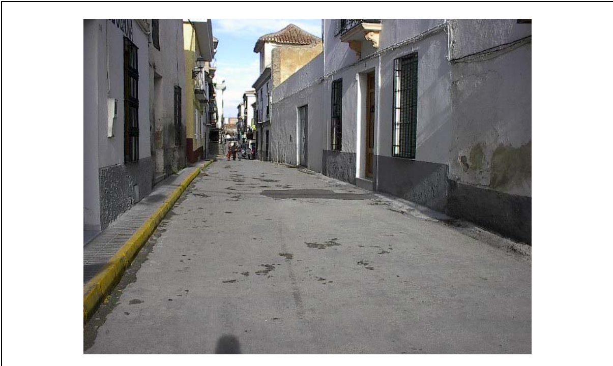
Foto 2 Ancho de aceras < 1,20 m. Sin acera en un lado
