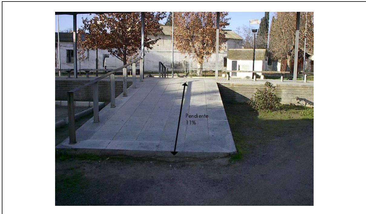
Foto 3 Rampa Altura de pasamanos 80 cm.
