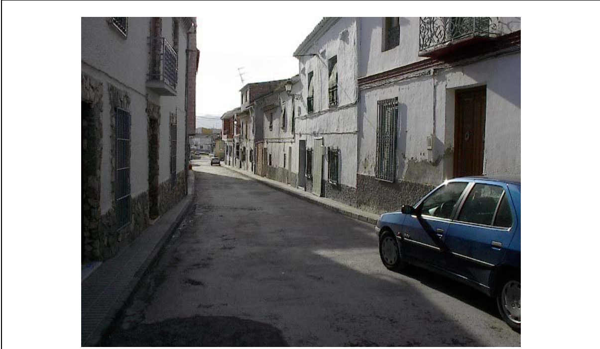
Foto 1 Ancho de aceras < 1,20 m.
