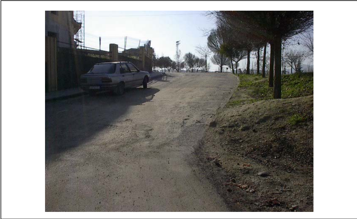
Foto 1 Acceso a Centro de Primaria. Pendiente >8%. Sin acera en un lado
