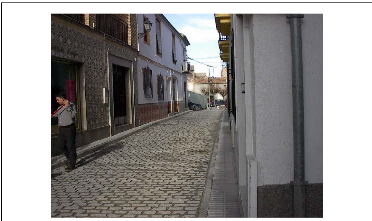
Foto 2 Ancho de aceras < 1,20 m.
