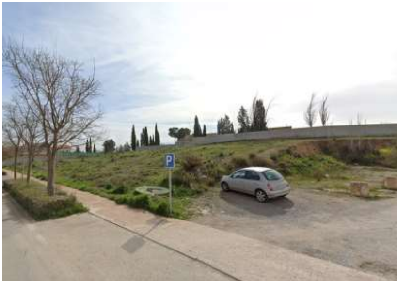
Fotografía 1. Zona de actuación
