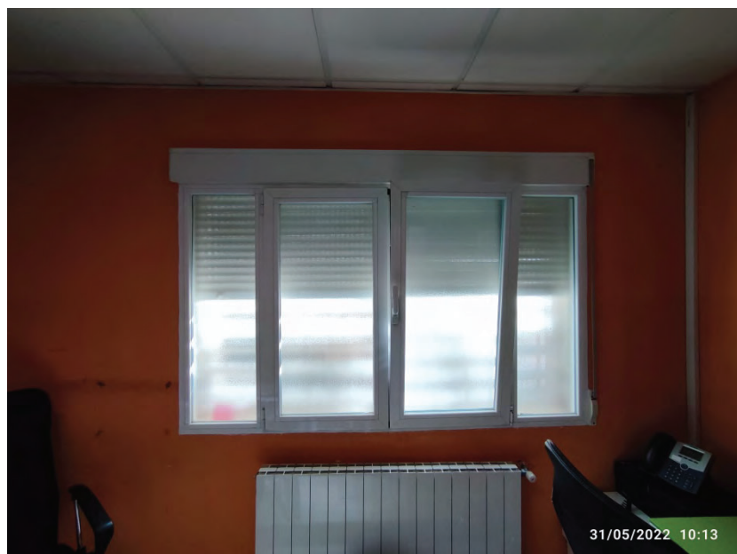
Carpinterías y radiadores a desmontar
