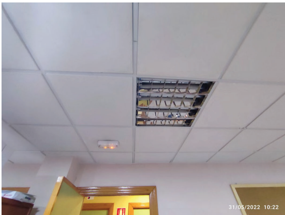
Interior oficinas. Luimnarias a desmontar
