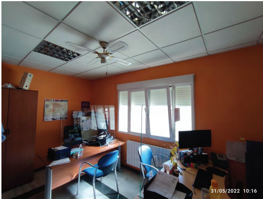
Interior oficinas. Falso techo escayola a desmontar
