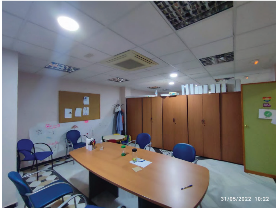
Interior oficinas. Suelo de mármol existente
