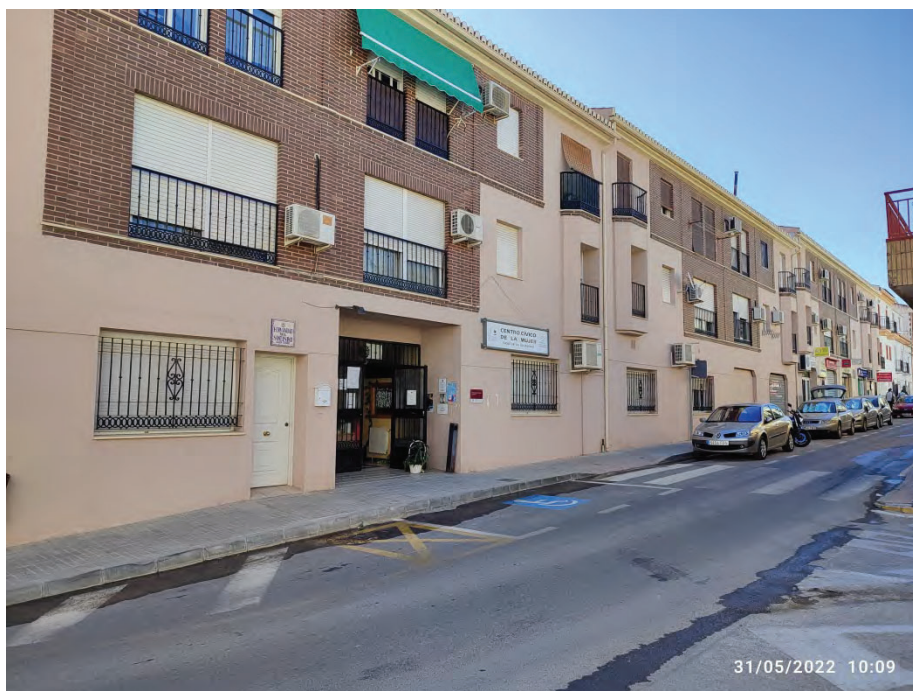
Fachada principal SO en calle de acceso
