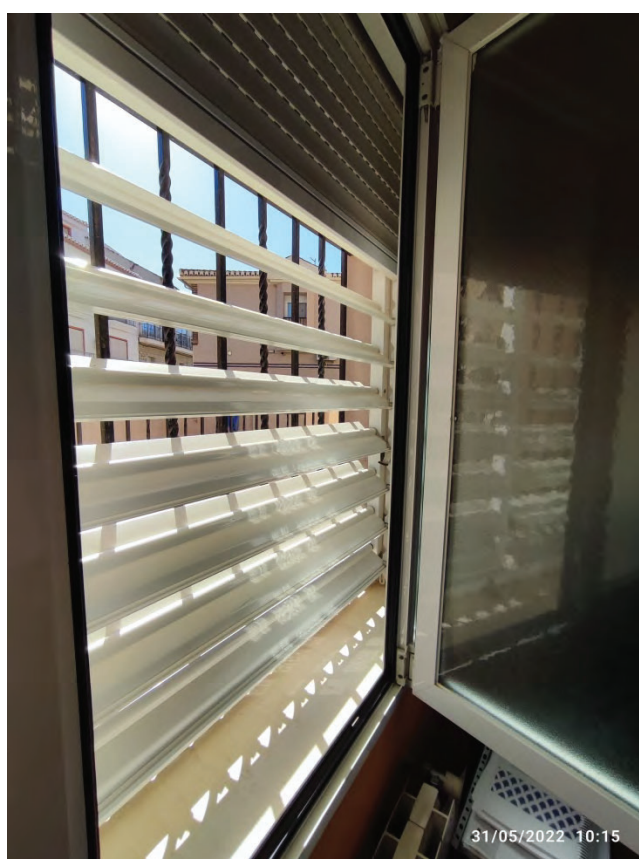
Lamas de aluminio en fachada posterior NE a conservar
