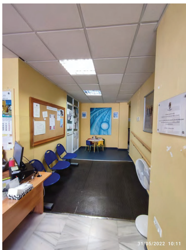
Interior oficinas. Rampa a demoler
