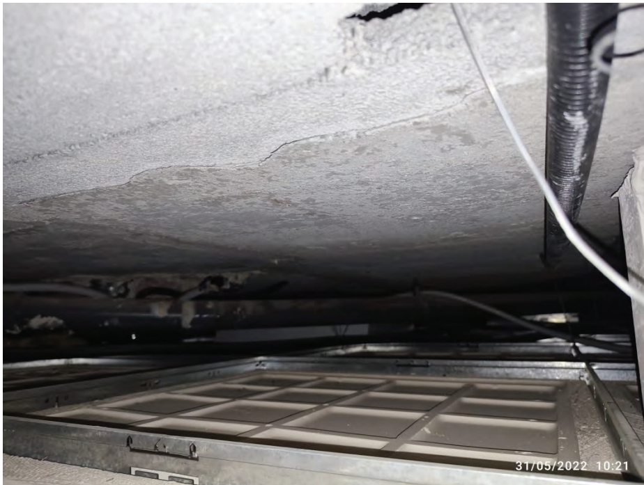
Espacio libre entre falso techo de escayola y forjado de planta primera
