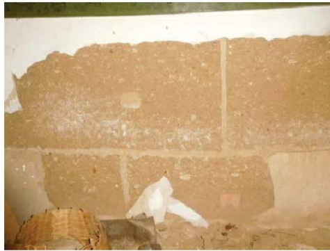
Muro de tapial.
