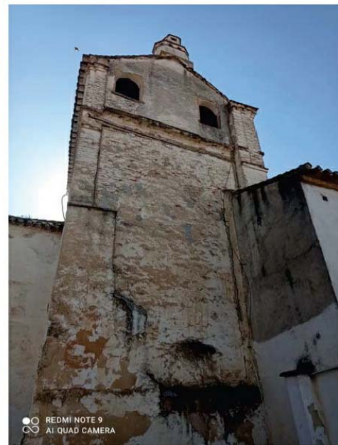
Alzado trasero del Torreón hacia patio del pozo
