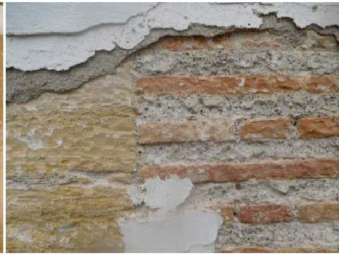
Muro de mampostería con fábrica de ladrillo.
