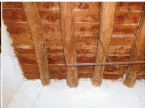
Armadura con rollizos de madera.
