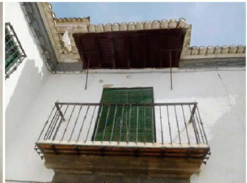
Sobrevuelo en cubierta de los balcones de fachada principal.
