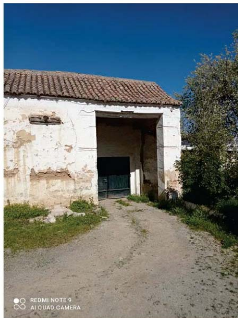
Acceso por Portón desde C/Aljivillo.
