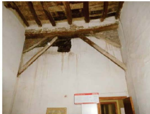
Estructura horizontal con parteluces
