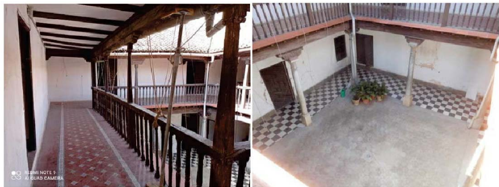
Galería y claustro patio castellano desde planta primera.
