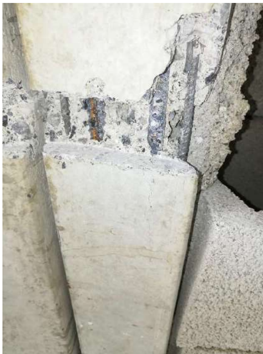
Figura 19.- Cata en vigüeta en paño de forjado entre muro y pórtico PH1-PH3
