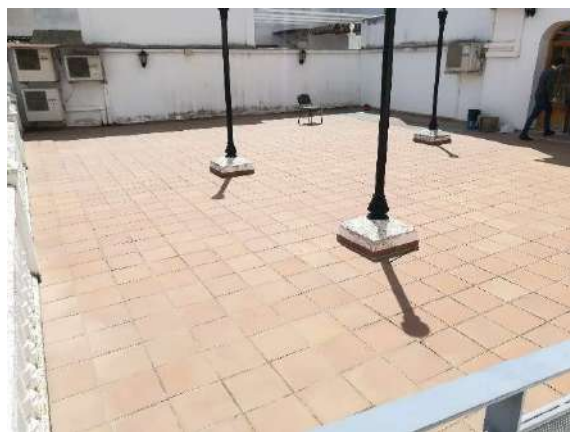
Figura 6.- Vista general de la terraza donde se pretende ejecutar la nueva planta
