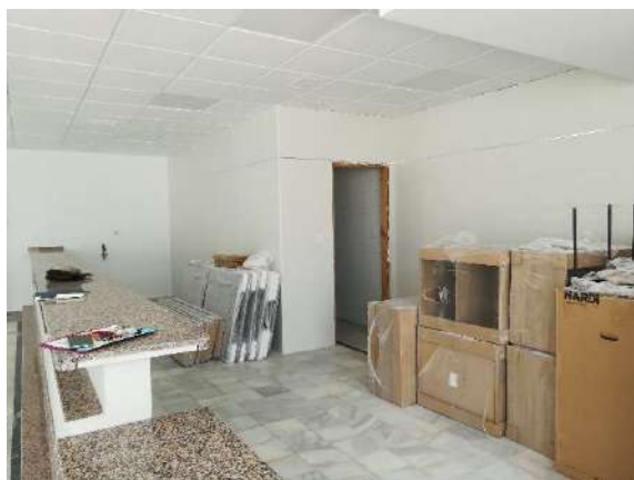
Figura 5.- Vista interior de planta baja. Zona barra y almacén
