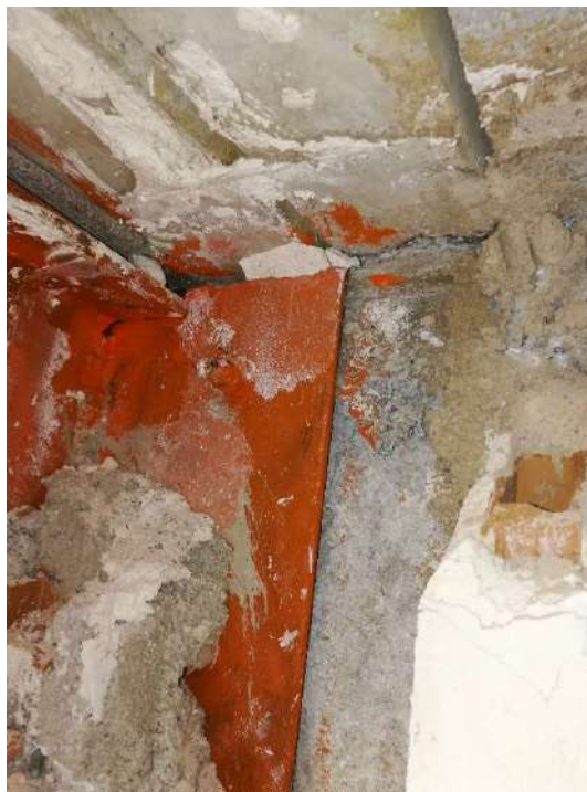
Figura 27.- Detalle de unión viga IPE330 a muro
