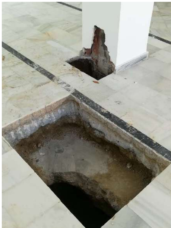
Figura 10.- Cata en zapata bajo pilar PH3
