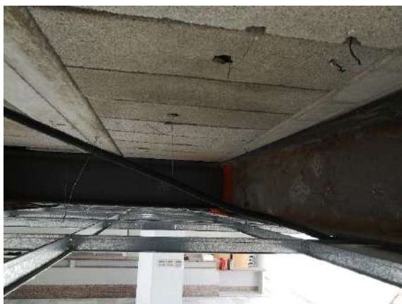
Figura 7.- Vista de refuerzo metálico bajo forjado
