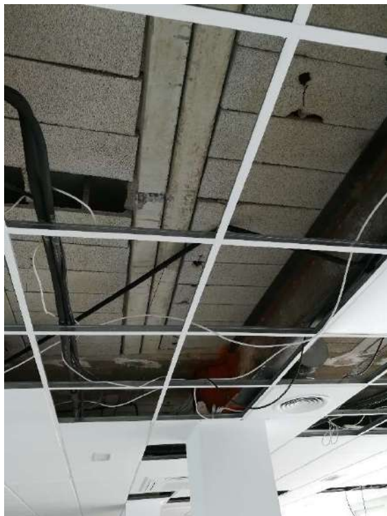
Figura 18.- Cata en vigüeta en paño de forjado entre muro y pórtico PH1-PH3
