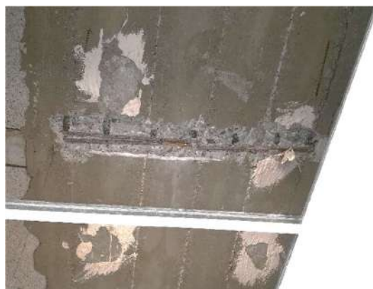
Figura 16.- Cata en viga entre pilares PH2-PH4
