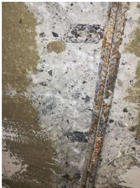
Figura 13.- Cata en viga entre pilares PH1-PH3
