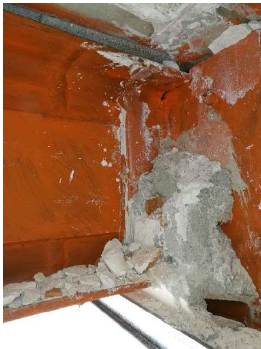
Figura 26.- Detalle de unión viga IPE330 a muro
