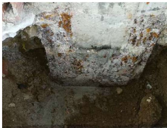
Figura 21.- Detalle refuerzo metálico en base pilar PH3.
