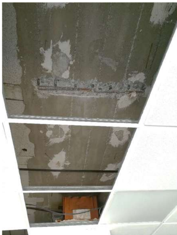
Figura 15.- Cata en viga entre pilares PH2-PH4
