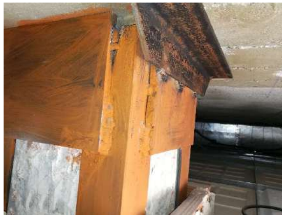
Figura 24.- Detalle refuerzo metálico en base pilar PH4.
