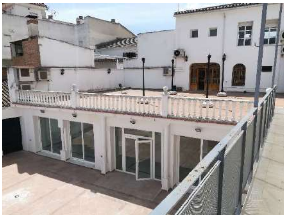
Figura 3.- Vista general de la zona de actuación. En la cubierta se pretende ejecutar la nueva planta
