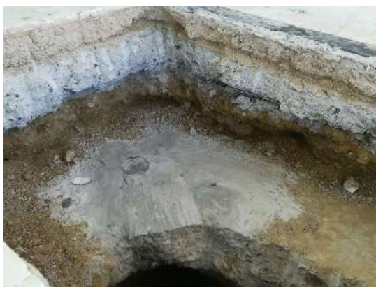
Figura 11.- Cata en zapata bajo pilar PH3
