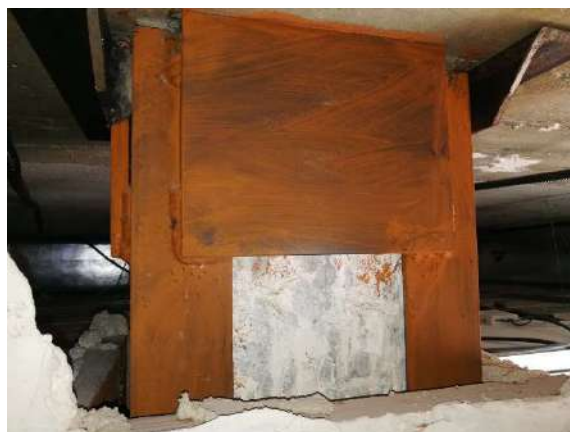
Figura 8.- Vista de refuerzo de pilar de hormigón mediante empresillado metálico
