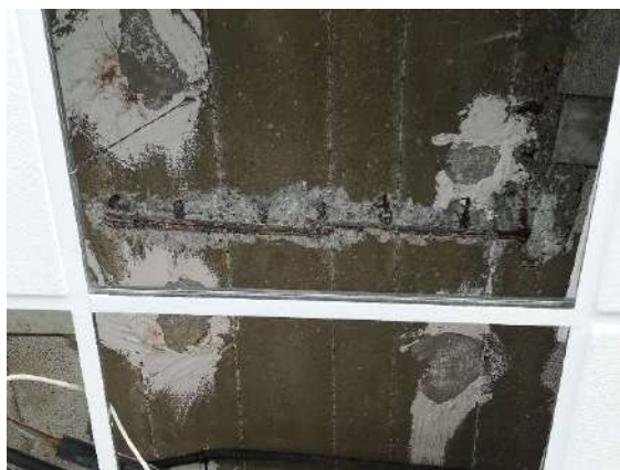
Figura 12.- Cata en viga entre pilares PH1-PH3
