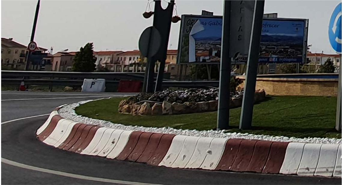
Detalle bordillo rotonda tipo bota pintado en dos colores, encintado de grava, césped artificial y jardineras de piedra existentes.
